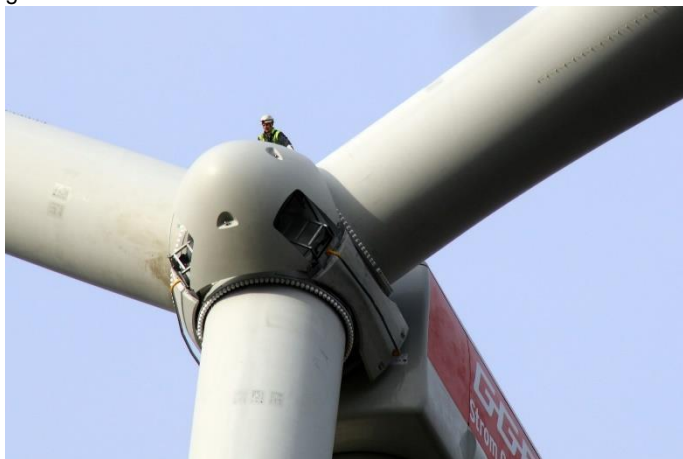
Bild: Bau der Windkraftanlagen auf dem Tannenkopf in Roßdorf, 2.Preis des Fotowettbewerbs von REG.eV, Foto: Sabine Schulz
